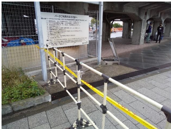
A-14：プラ柵設置場所 (コーションテープで補強)
