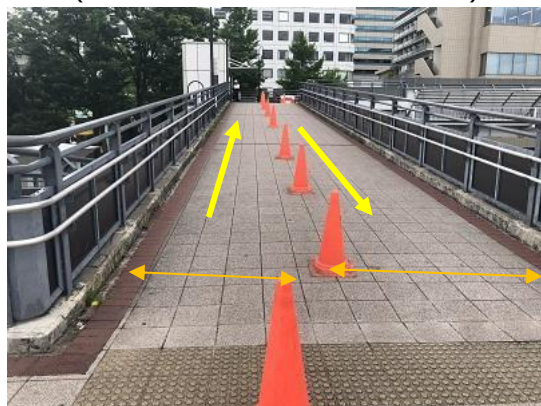
T12 : ローソン横スロープ (下り側のコースを少し広めに設営する)
